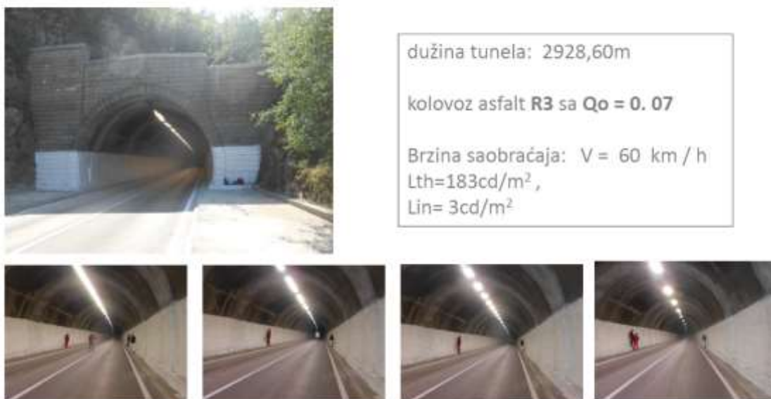
Slika 44. Osvjetljenje tunela Budoš na magistralnom putu Niksić – Podgorica [24]
