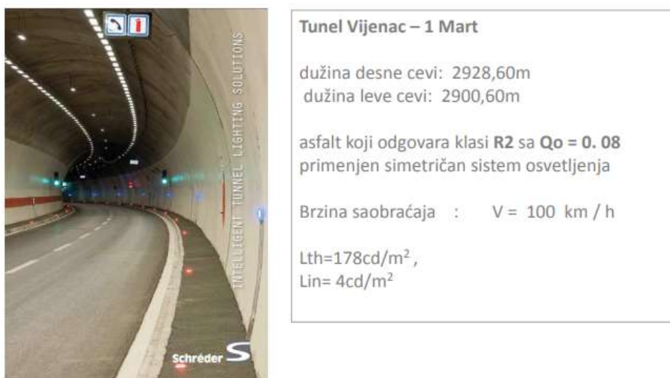
Slika 15. LED tehnologije u tunelskom osvjetljenju- tunel Vijenac - 1 Mart, Bosna i Hercegovina [5]
