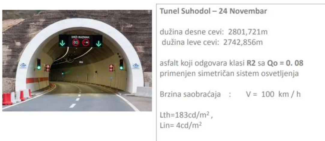
Slika 16. LED realizacija u regionu Tunel 24 Novembar na koridoru Vc, BiH [5]
